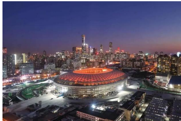
北京工人体育馆
